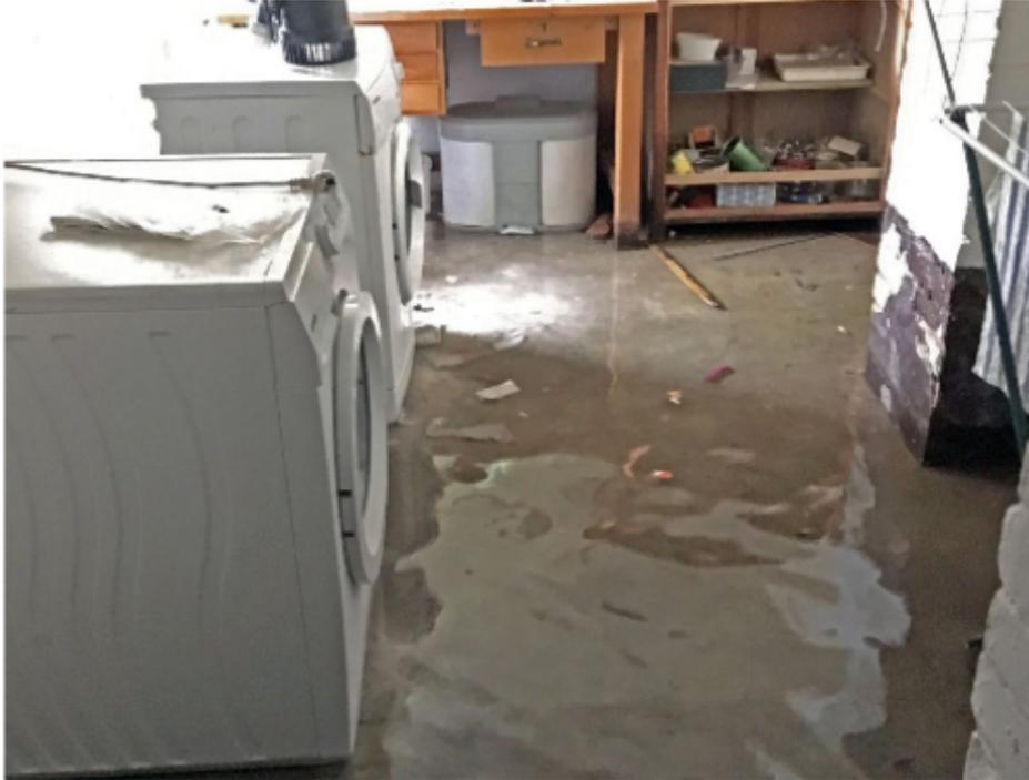
Wasserschaden durch Rohrbruch im Keller
